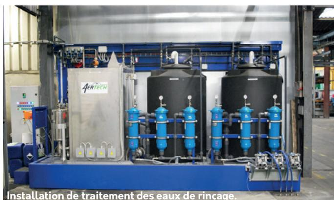
Installation de traitement des eaux de rinçage.
