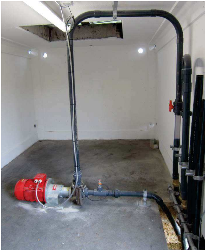
Hebestation mit Frequenzumrichter und Schaltschrank
